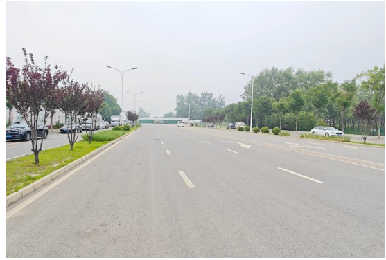
项目西侧现状道路
