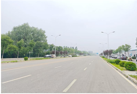
项目南侧现状道路
