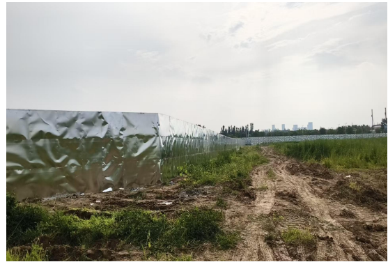
项目北侧围挡
